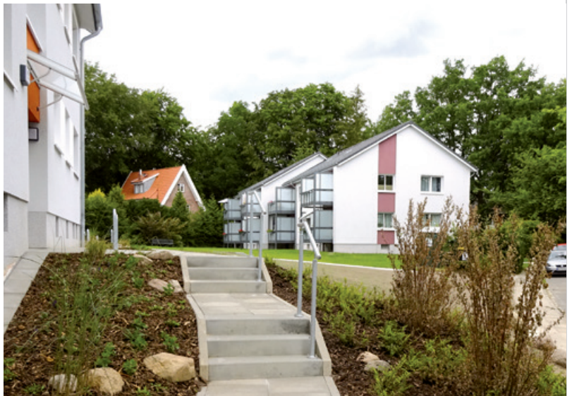
Einblick in die Außenanlagen unseres Modernisierungsprojektes in Großhansdorf
