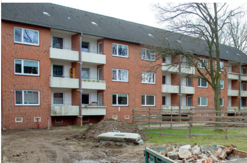
3. Bauabschnitt unserer Modernisierungsarbeiten in Wentorf
